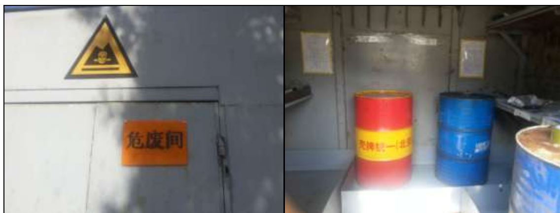
图4.1-5 本项目危险废物暂存间
